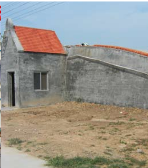
De traditionele Chinese kas kent een simpel, maar doeltreffend systeem van warmteopslag.
