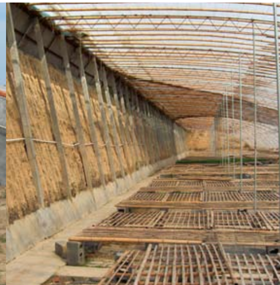
De traditionele Chinese kas kent een simpel, maar doeltreffend systeem van warmteopslag.
